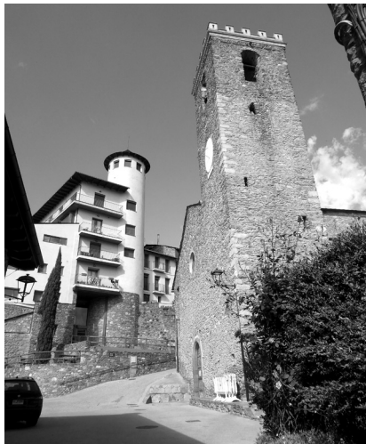
Edifici "torreó", construït sobre l'antiga muralla, i campanar de l'actual església parroquial de Sant Vicenç de Montferrer. Fotografia: Lluís Obiols i Perearnau
